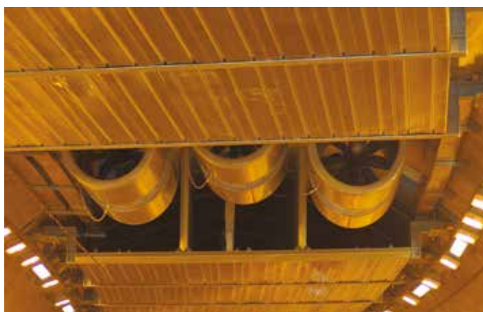
11. Un particolare di ventilatori e fonoassorbenti in calotta presso la galleria Valsassina
