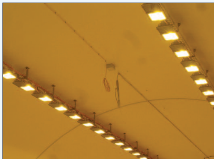
3. Un particolare di posa in opera del cavo
